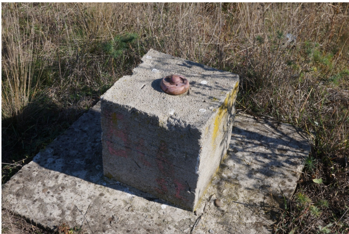
Bornă topografică amplasată pe digul de compartimentare
