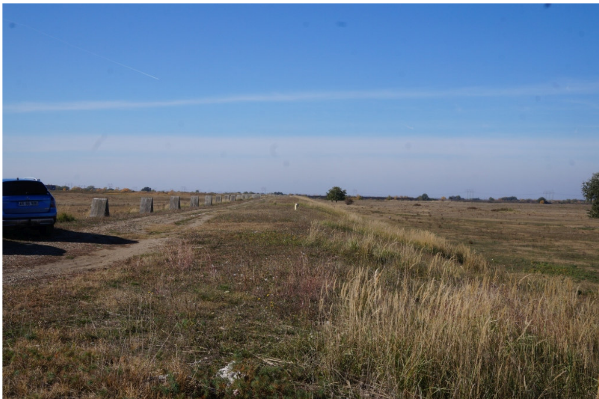
Digul de compartimentare între Compartimentele 2 și 3
